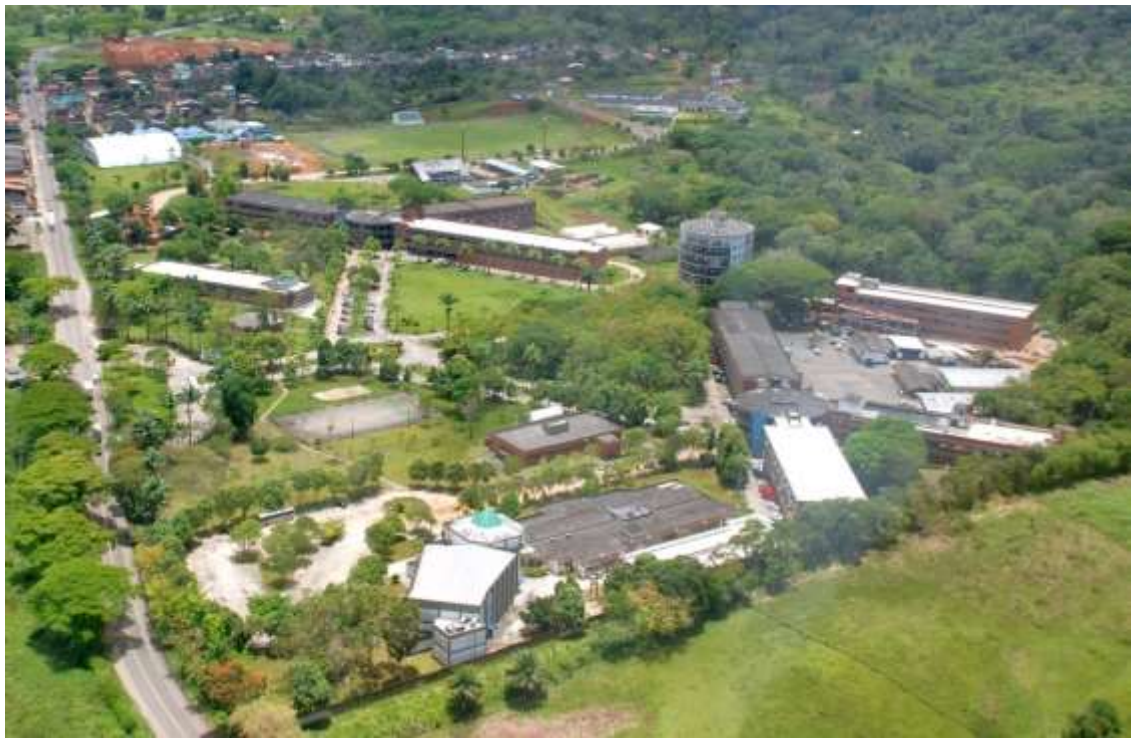
Figura 1 – VISTA AÉREA DO CAMPUS, 2016.
