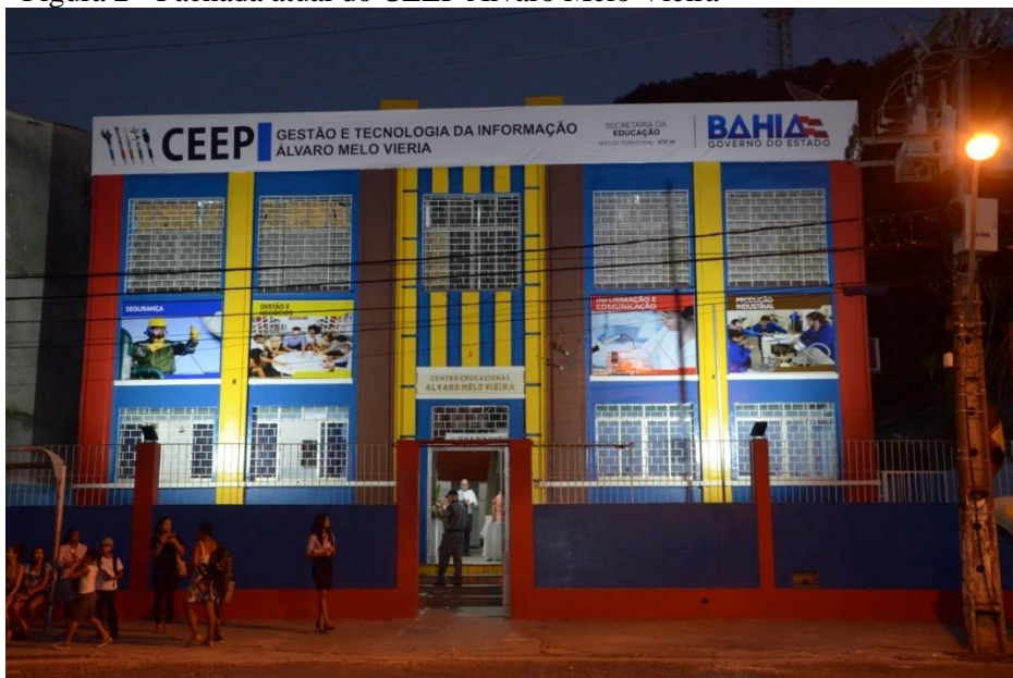
Figura 2 - Fachada atual do CEEP Álvaro Melo Vieira
